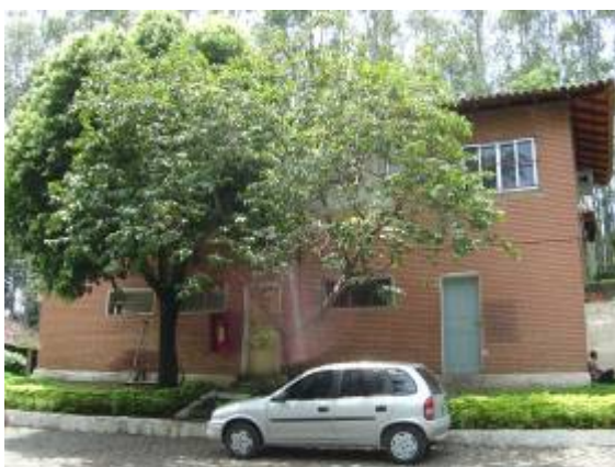
Figura 15: Edifício da Informática
