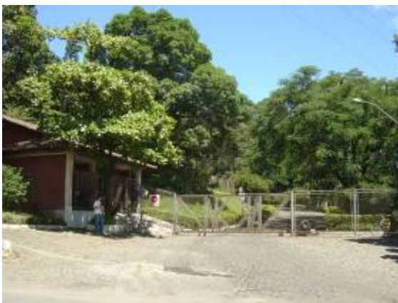
Figura 10: Vista da portaria e do portão da CBF
