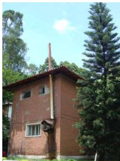
Figura 16: Edifício da Informática
