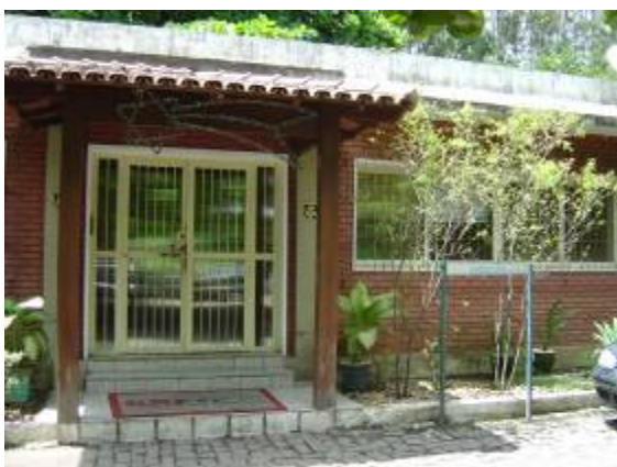
Figura 24: Entrada do edifício
