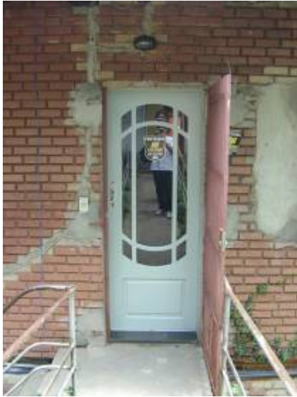
Figura 50: 01 – Entrada do edifício
