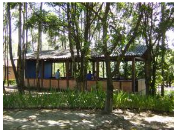
Figura 54: Vista da área de lazer coberta
