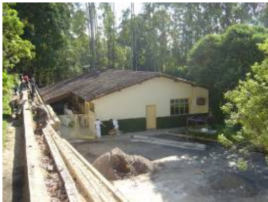
Figura 213: Edifício com a sala arquivo/prestadores de serviço.
