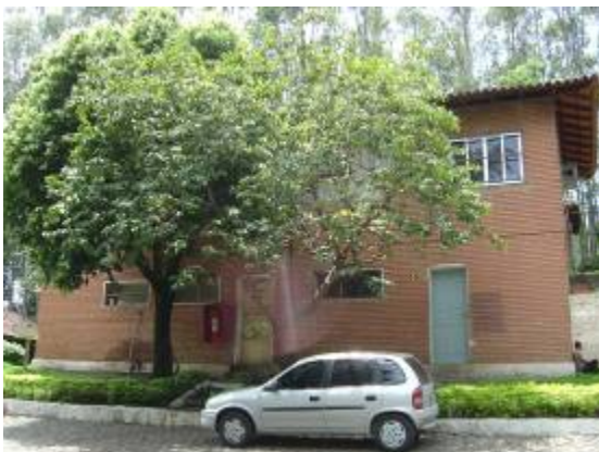
Figura 205: Edifício do setor de informática, o acesso ocorre na parte posterior do edifício.
