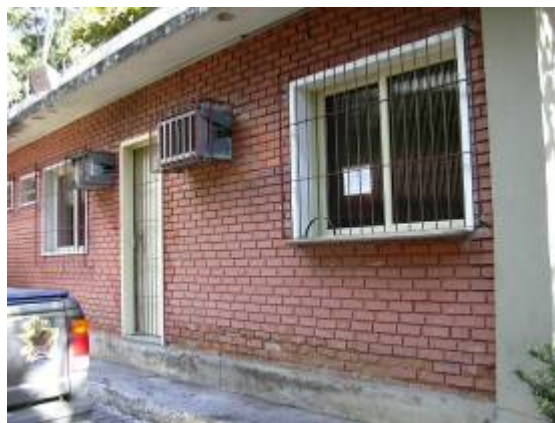
Figura 202: Janela de atendimento do departamento pessoal e porta de acesso ao departamento médico.
