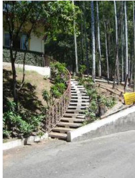
Figura 175: A escada da rua para o restaurante
