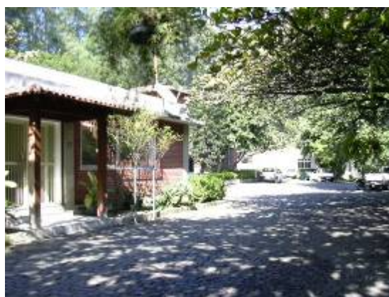
Figura 184: Edifício da informática à esquerda e edifício do refeitório ao fundo.
