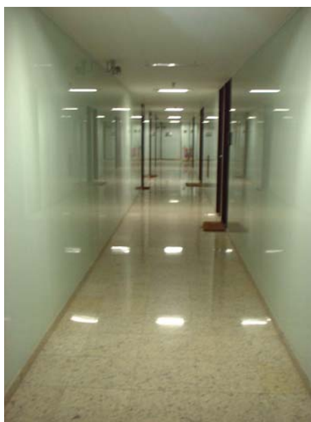
Fig.137: Corredor do edifício Foto: da autora, 2003
