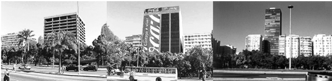
Figura 8 – (a) Edifício Caemi; (b) Edifício Coca-Cola/Intelig; (c) Edifício 440 – “Transatlânticos na Calçada”
