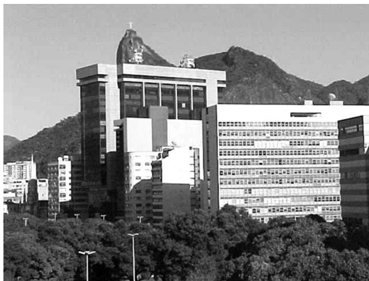
Figura 9 – Vista da janela da sala do meu antigo apartamento, no sétimo andar: bloqueio da vista do perfil das montanhas especialmente do Corcovado.
