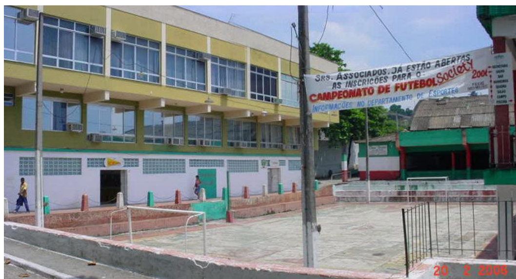
Fig. 4.14 – O prédio no qual se encontra a sala da Repartição A, no interior do clube.
